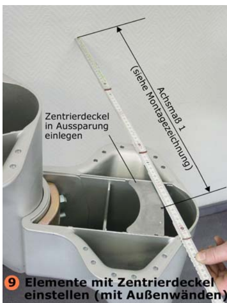
10 Elemente mit Zentrierdeckel einstellen (mit Außenwänden)
