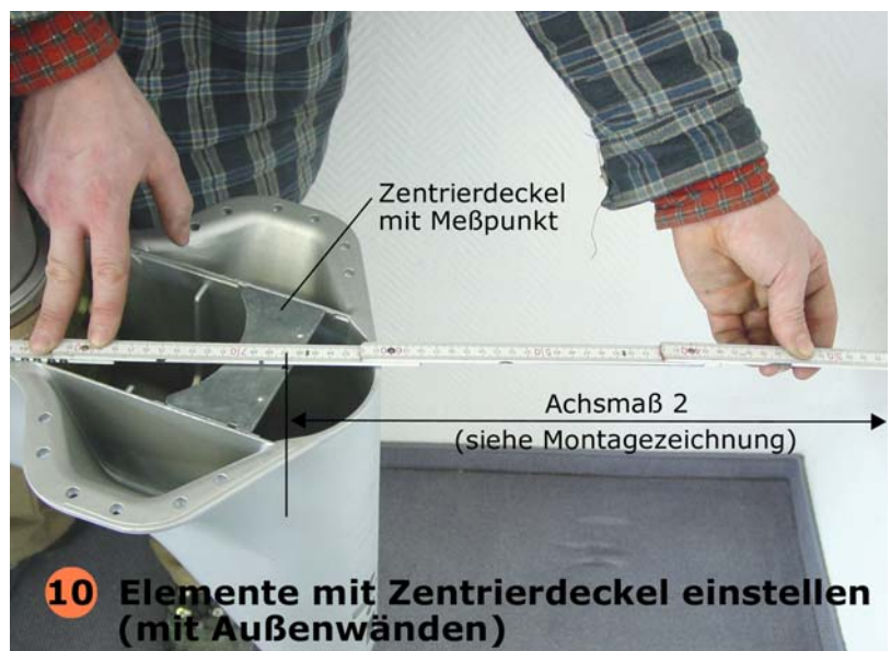
9 Elemente mit Zentrierdeckel einstellen (mit Außenwänden)
